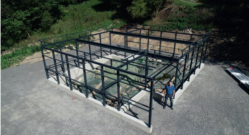
Abb. 25: Herbst 2019: Das Fundament sowie die Tragkonstruktion für Dach und Wände des Schutzbaus stehen (Foto: LWL-Archäologie für Westfalen/M. Zeiler).
