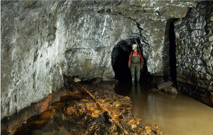
Abb. 14: Blindschachthalle Grube Landeskrone, Blick von Südosten auf den Zugang des Tiefen Stollens, den Blindschacht (im Vordergrund links verschüttet) sowie (hinten rechts) abgehende Bereiche in den darüber liegenden Altbergbau (Foto: LWL-Archäologie für Westfalen/T. Poggel).
