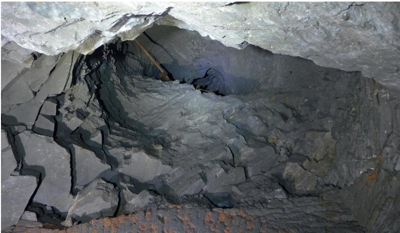
Abb. 21: Blick nach oben in den Überhau zur Bewetterung der Schachthalle (Foto: R. Golze).
