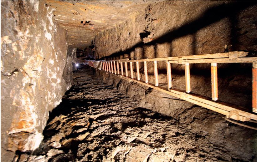
Abb. 15: Ausgemauerte Fahrung im Liebfrauentgang mit rezentem Leiterausbau (Foto: LWL-Archäologie für Westfalen/M. Zeiler).
