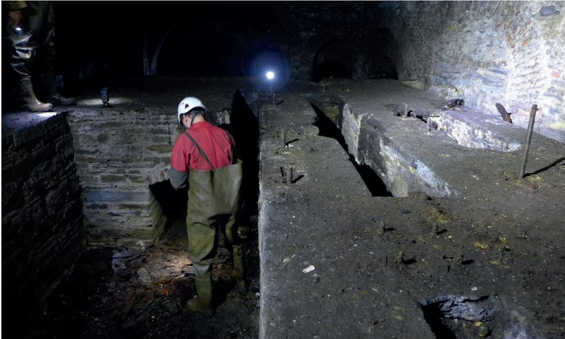
Abb. 25: Dampfmaschinenplattform (Blickrichtung Schachthalle). Am linken Bildrand befindet sich die Aussparung der Seiltrommel, rechts die des Schwungrades der Dampfmaschine, zum Teil mit herausragenden eisernen Fundamentschrauben (Foto: R. Golze).
