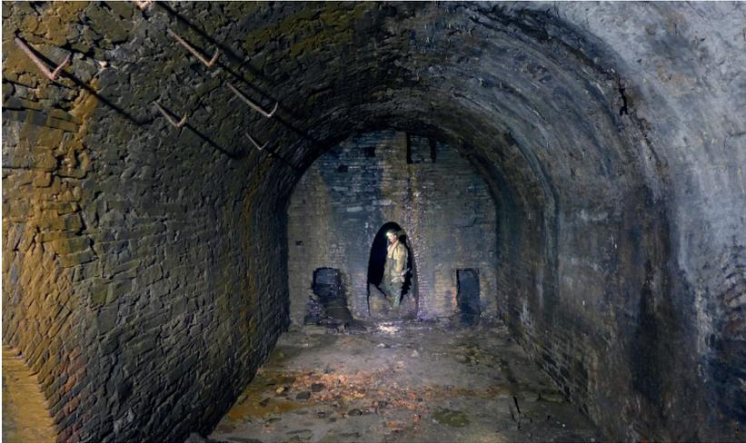
Abb. 23: Blick von der Dampfmaschinenplattform in die Kesselhalle. Am linken Bildrand öffnet sich die Kesselhalle (Zugang nur im Ansatz erkennbar) zur parallel vorbeiführenden Strecke. Die beiden schwarz gefärbten Maueröffnungen in der Stirnwand dienten als Rauchgasabzüge der zwei ehemals vorhandenen Dampfkessel (Foto: R. Golze).
