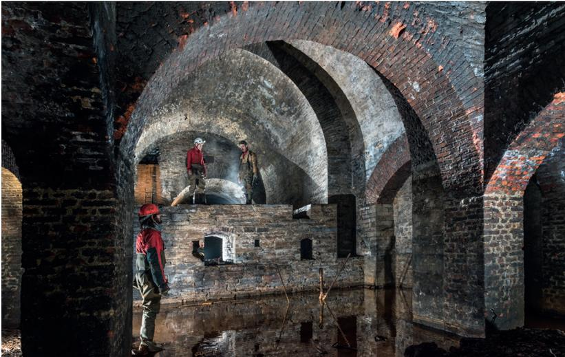
Abb. 26: Blick durch die Schachthalle auf die Dampfmaschinenplattform in der Bildmitte. Im Hintergrund (erleuchtet) ist das Tonnengewölbe der Kesselhalle erkennbar (Foto: Deutsches Bergbau-Museum/P. Thomas).
